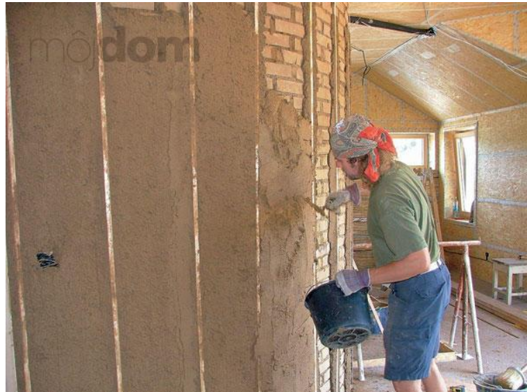
Nahadzovanie priečky z nepálených tehál hrubou hlinenou omietkou. Po zaschnutí sa na ňu naniesie začisťovacia omietka. (zdroj: www.mojdom.zoznam.sk )
